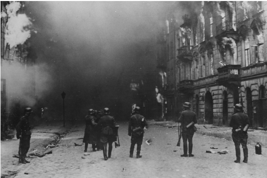
14. Bildteil des Stroop-Berichtes Nr. 200/5045, Sp. 1 Die Wohnhäuser im Warschauer Ghetto werden systematisch in Brand gesteckt.
